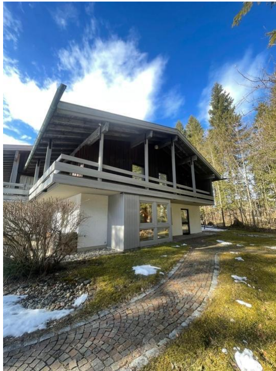
Ansicht Ost - Zugang ELW
