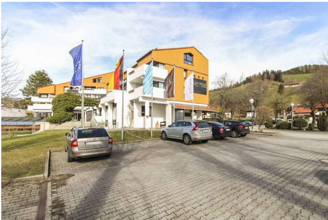
Eingangsseite und Parkplatz
